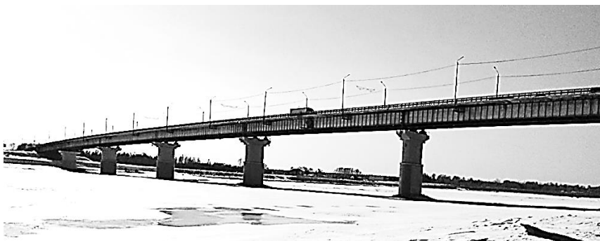
Рис. 18.2. Мост на р. Томь (построен вместо понтонного в 1972 г.)
